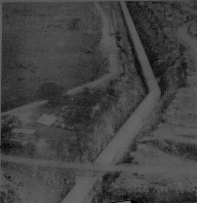
Vista aérea de la Tubería de Trinchera.
